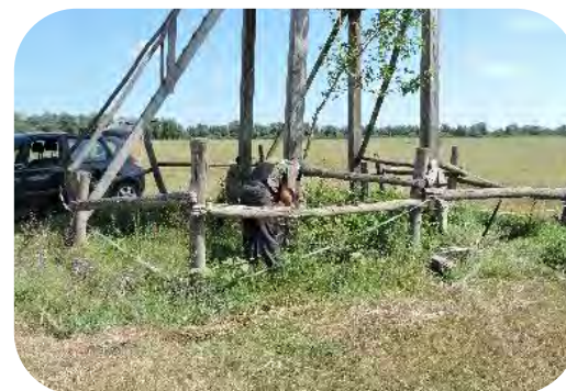
Popravci čardaka BED
