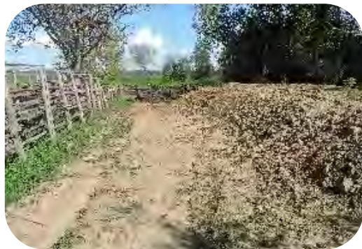
Radovi na infrastrukturi – protupoplavni platoi – Hrvatske vode
